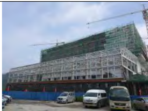
主体工程施工围挡
