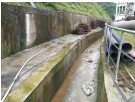
厂区排水明沟 1
