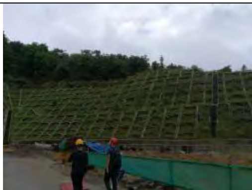
厂区护坡绿化 2
