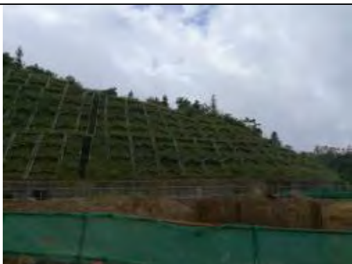
厂区护坡绿化 1
