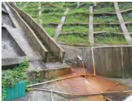
厂区排水明沟 2
